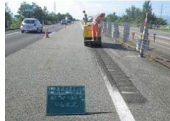
切削施工状況 この後スィーパーで廃材を集めます
