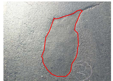
供用時の常温混合物の様子①
